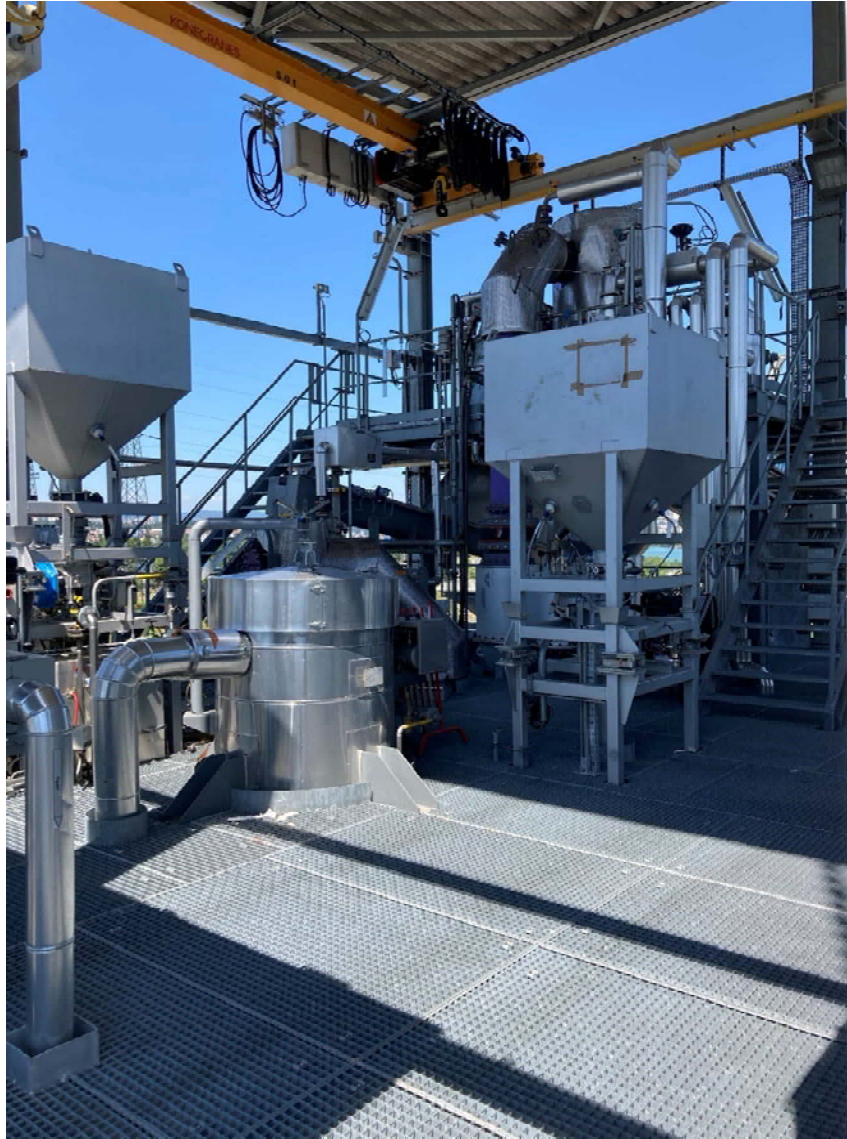
Figure 5 : autre angle de vue de l'avant-dernier étage de la plateforme où les travaux précités seront réalisés
