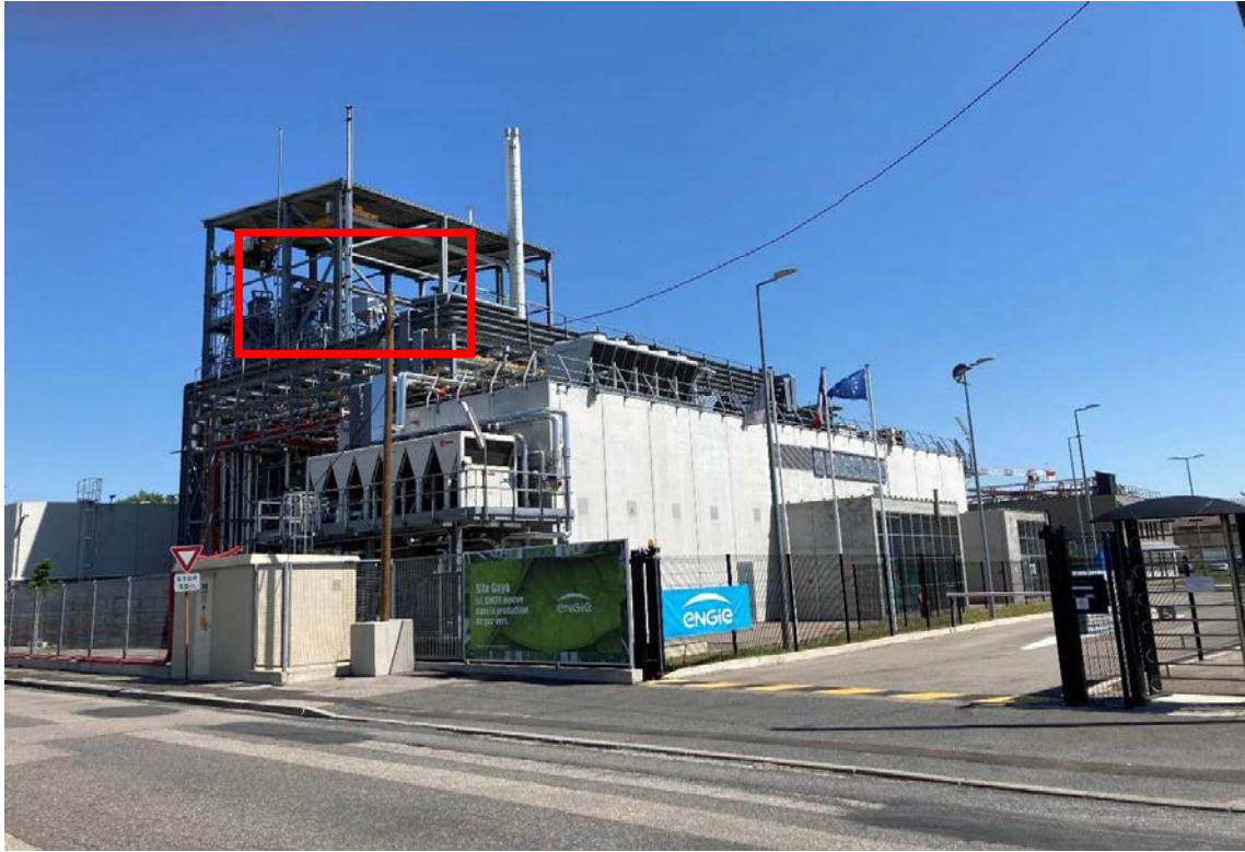
Figure 1 : prise de vue de la plateforme vue de l'extérieur, c'est-à-dire depuis le Quai Louis Aulagne. L'encadré rouge indique la zone dans laquelle les travaux seront réalisés
